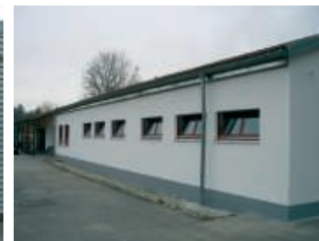
... und nach der Renovierung 2011.
